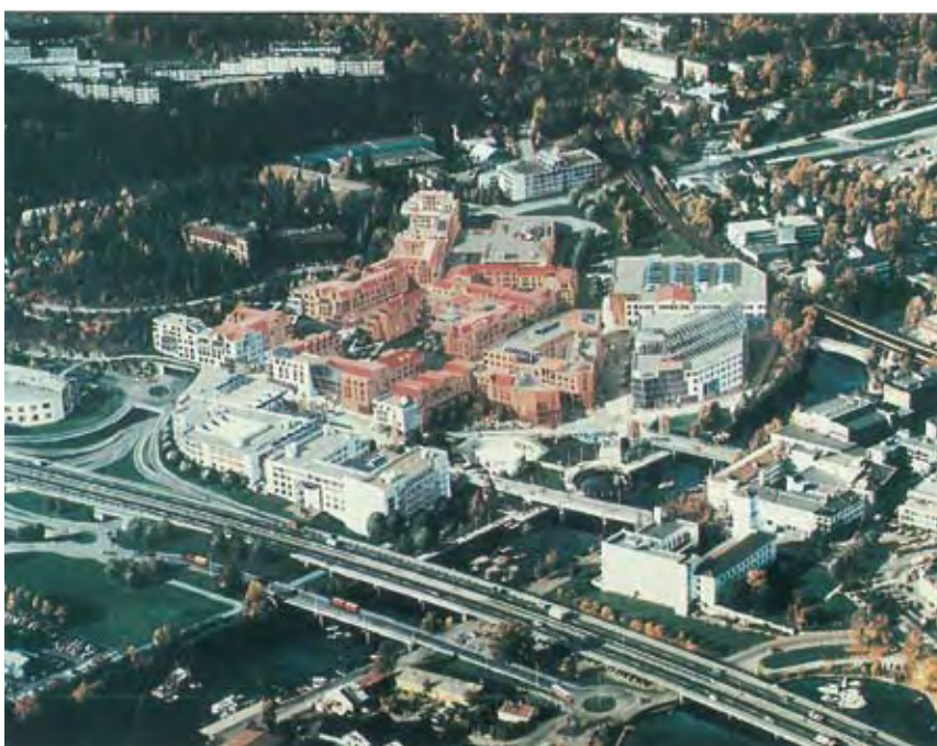
Das mit Abwasserenergie versorgte Zentrum von Sandvika.
