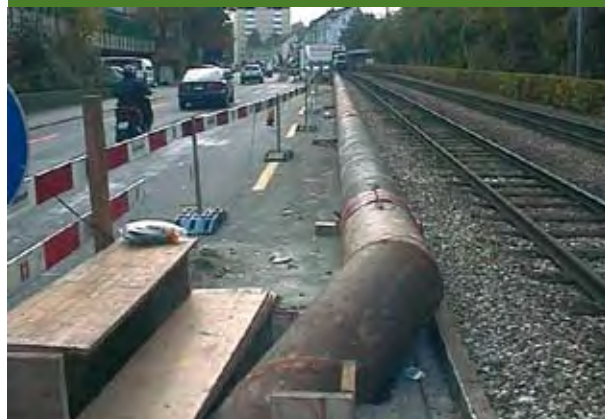
Umleitung des Abwassers während der Bauzeit. (Foto EBM)
