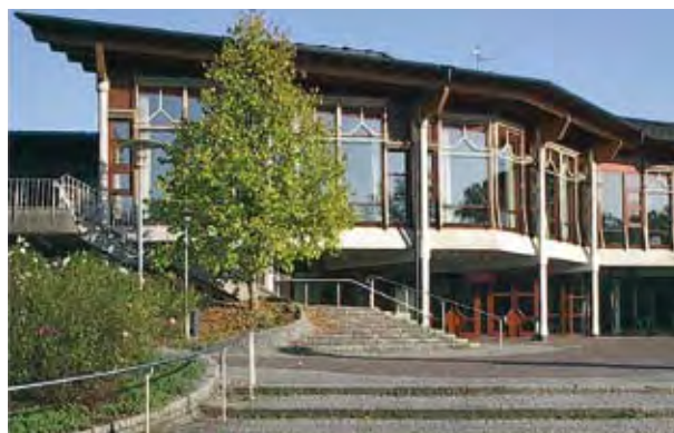
Das Bürgerzentrum von Waiblingen: seit 20 Jahren mit Wärme aus Abwasser beheizt.
