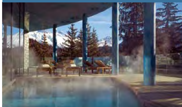
Luxus-Hotel Carlton, St. Moritz: Energierückgewinnung aus dem hauseigenen Abwasser.
