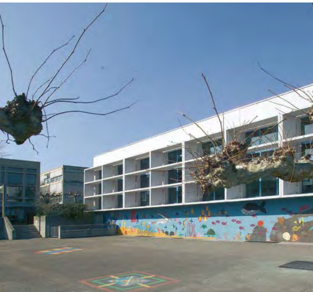
Anschauungsunterricht für kommende Generationen: Das Schulhaus Spiegelfeld in Binningen bei Basel wird mit Abwasserwärme geheizt. Der Strom für den Antrieb der Wärmepumpen wird mit einem Gas-Blockheizkraftwerk erzeugt.
