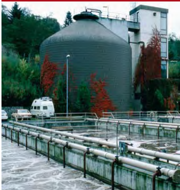
Die Kläranlage Waiblingen produziert Ökowärme und Ökostrom.
