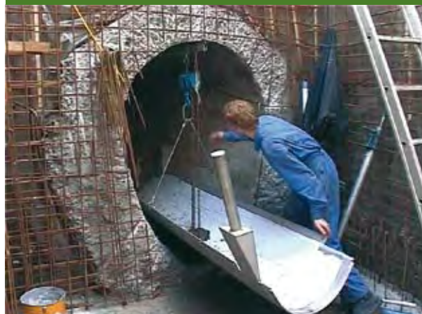
Einbringen des Wärmetauschers in einen bestehenden Kanal. (Foto: Kasag)
