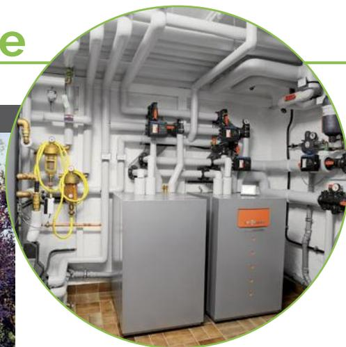
In einem 60 Jahre alten Sandsteingebäude konnte ohne weitere Sanierungsmaßnahmen eine Wärmepumpe installiert werden. Die Erdwärmepumpe kommt trotz alter Radiatoren auf eine beachtliche Jahresarbeitszahl von 3,5.
