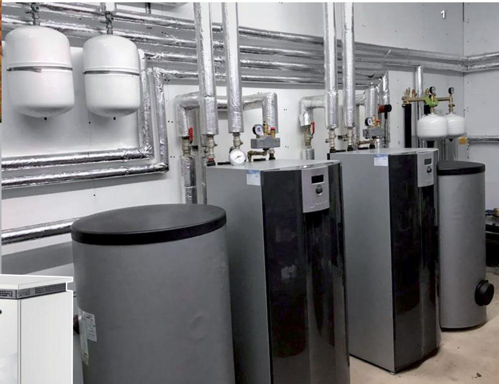
1. Mit Hilfe eines großzügig dimensionierten, gut gedämmten Wärmespeichers lassen sich Stromüberschüsse nutzen. 2.+3. Mit Hilfe einer Hausbatterie lässt sich selbst erzeugter Strom speichern, bis er beispielsweise von der Wärmepumpe gebraucht wird.
