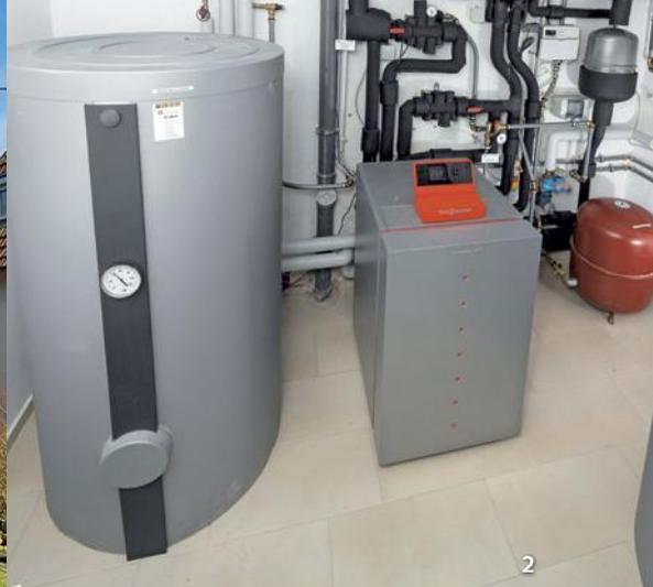
1. Die Umbauphase. 2. Blick auf den aufgeräumten Heizraum mit der Wärmepumpe. 3. Insgesamt sind auf den Dachflächen – außenseitig gedämmt und neu mit Biberschwanzziegeln eingedeckt – vorne und hinten zwanzig Quadratmeter Solar-Luftabsorberfläche montiert.
