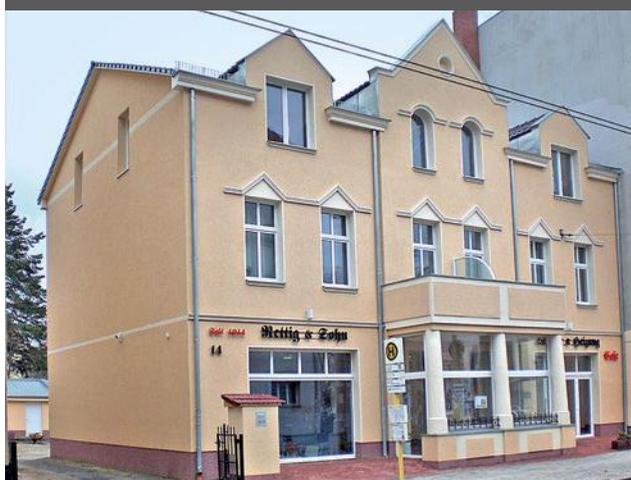
Das Gebäude aus dem 19. Jhd., das 14 Jahre leer stand, wurde 2007 von Detlef Rettig erworben und umfassend saniert. Eine Luftwärmepumpe auf dem Dach des Seitenanbaus, neue Fenster, eine Abluftanlage sowie eine gute Wärmedämmung sorgen für eine hohe Effizienz des Energiegesamtkonzepts auf dem Niveau der Energieeinsparverordnung für Neubauten.
