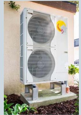
**Smart geregelt** Die Leistung der Luft-Wärmepumpe wird der aktuellen Solarstromleistung angepasst.
