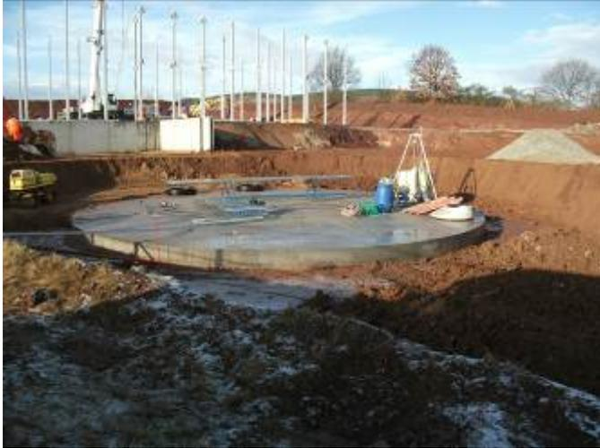
**Isocal 3:** Herzstück des SolarEis-Systems ist der im Boden eingelassene 500.000 Liter-Wassertank, der den Sommer über aufgeheizt wird und der als Wärmequelle für die Wärmepumpe dient.
