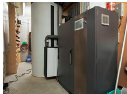
Im Keller von Ildiko Sugars Einfamilienhaus findet sich neben einer Luft/Wasser-Wärmepumpe ein Pufferspeicher. Dieser wird mit überschüssiger Energie gespeist, die die Wärmepumpe bei Sonnenschein mit Solarstrom produziert.
