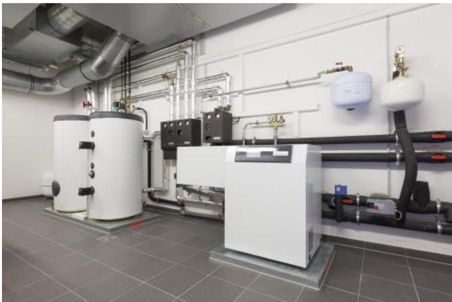
Die Sole/Wasser-Wärmepumpe mit drei Sonden von Weishaupt hat eine Heizleistung vom 10,9 kW.
