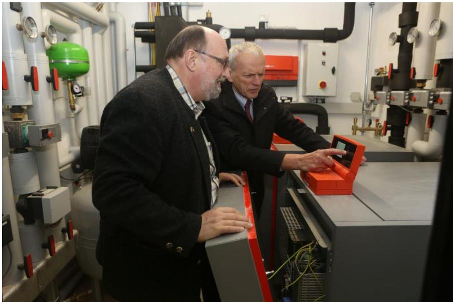
Die beiden Grundwasser-Wärmepumpen werden mit eigenem PV-Strom betrieben und versorgen das Verwaltungsgebäude des Ziegelhofs mit Heizwärme. Links Horst Erhardt, Geschäftsführer der Stiftung Bunter Kreis, rechts Arno Pöhlmann, LEW.
