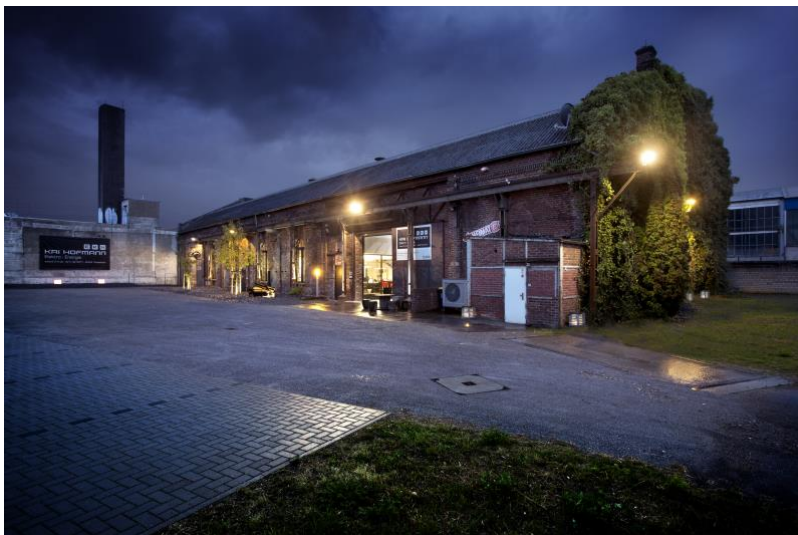
Die alte Backsteinhalle in Düsseldorf wird mit einer Luftwärmepumpe beheizt (Bildquelle: EKH).
