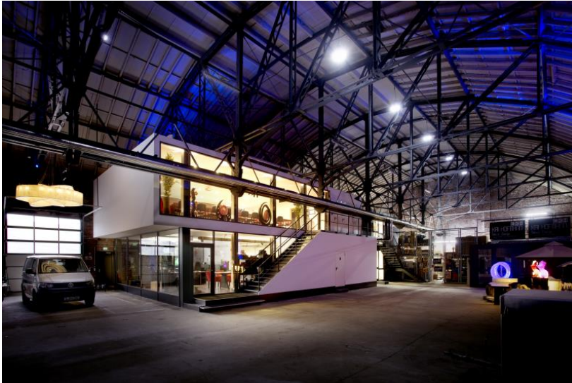
Die versetzt übereinanderliegenden Bürocontainer bilden ein eigenes Gebäude innerhalb der Waagenhalle (Bildquelle: EKH).
