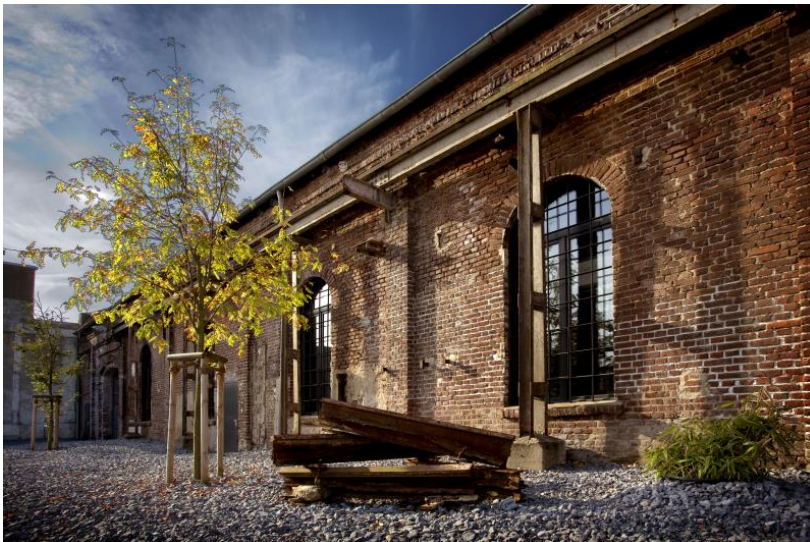
In der 1904 erbauten Industriehalle glänzt heute ein Showroom mit modernster Gebäudetechnik (Bildquelle: EKH).
