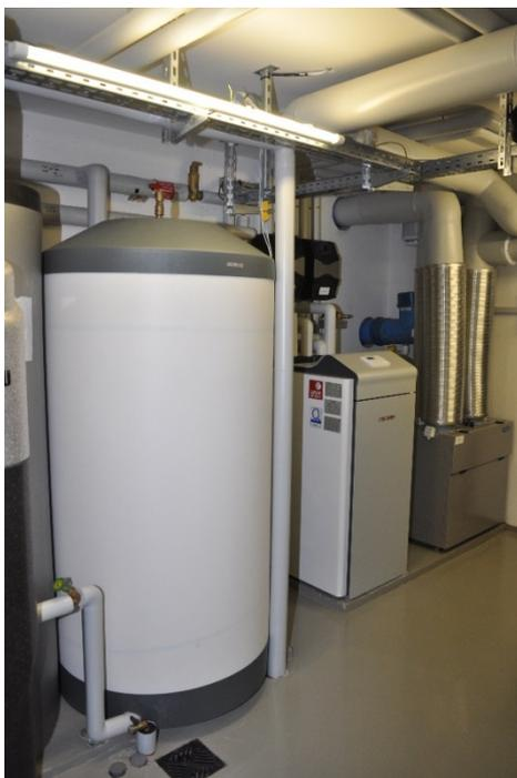
**05\_EnergiePlus\_Wohnhaus:** Zwei in Serie geschaltete Pufferspeicher ermöglichen die Produktion von Wärme für Heizung und Trinkwasser in den Stunden, in denen die Solaranlage besonders viel Stromertrag bringt.
