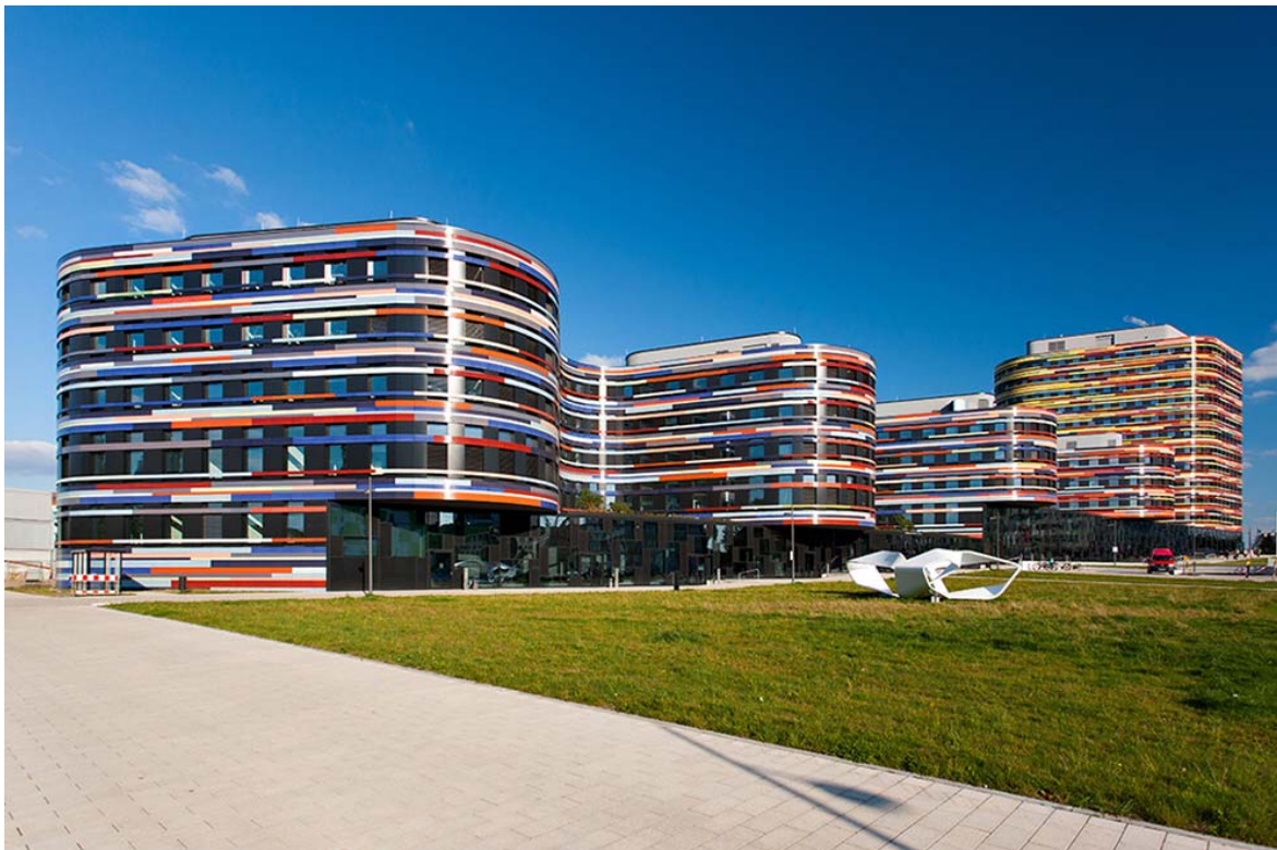
01_BSU: Die DGNB zeichnete den Neubau der Behörde für Stadtentwicklung und Umwelt (BSU) in Wilhelmsburg mit dem goldenen Zertifikat aus. (Bildquelle: Sprinkenhof GmbH / Franziska Glück)
