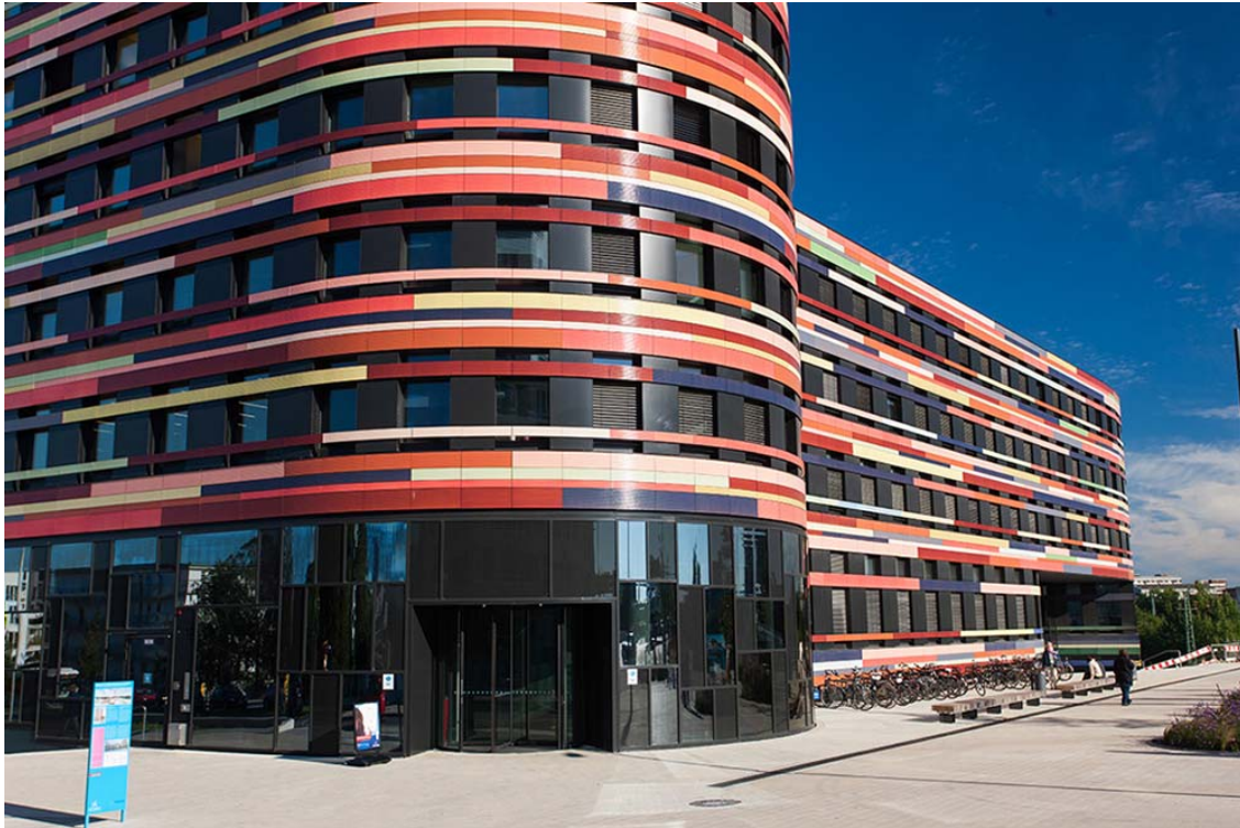
02_BSU: Geheizt wird das 2013 fertiggestellte Gebäude mit Wärmepumpe. Diese nutzt die Wärme aus 1.600 Energiepfählen und bringt sie auf ein höheres Temperaturniveau. (Bildquelle: Sprinkenhof GmbH / Franziska Glück)
