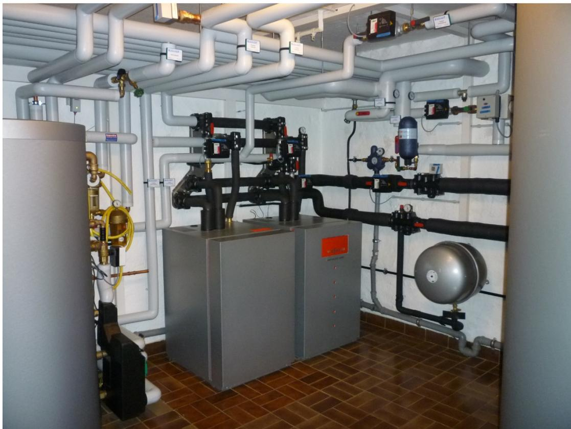
**02\_Sandsteinvilla Stuttgart:** Die beiden Viessmann Vitocal 300-G wandeln die Erdwärme in angenehme Raumwärme um. Sie sind in einer Master/Slave-Schaltung installiert und müssen deswegen nicht beide rund um die Uhr im Einsatz sein.
