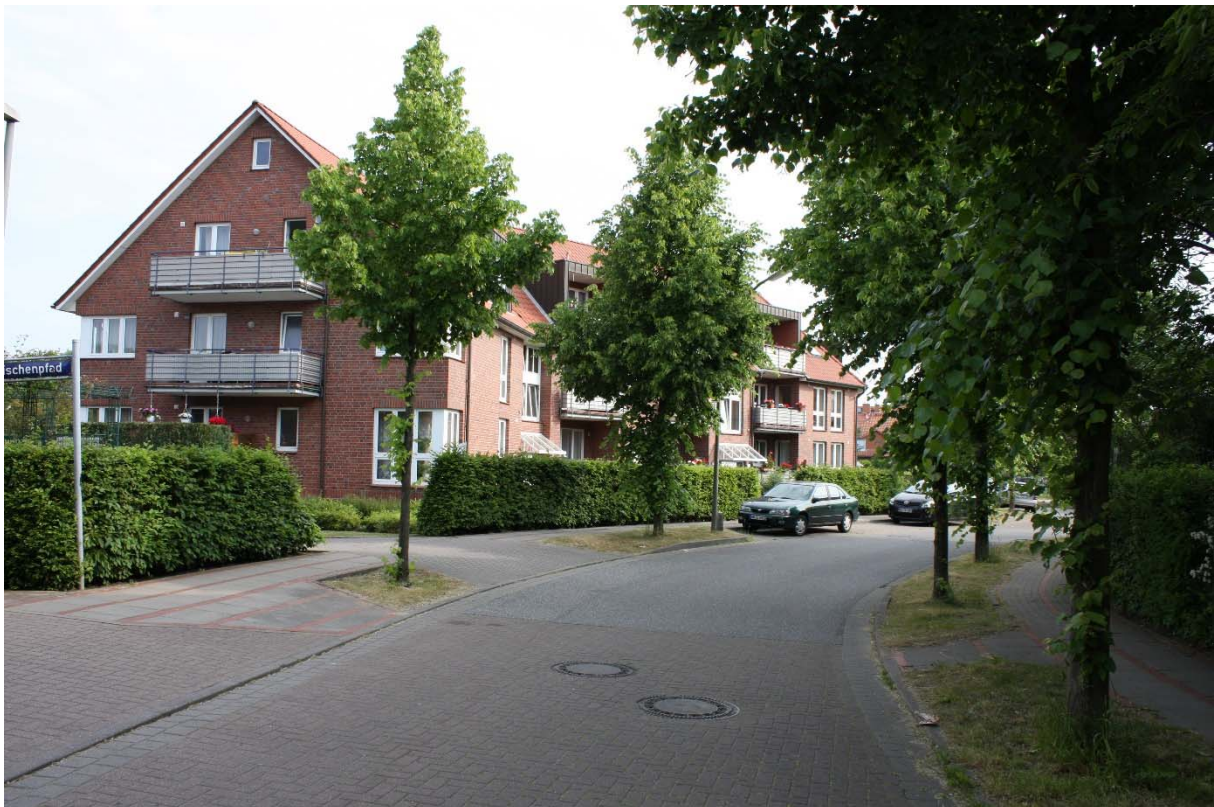
01_MFH_NIBE: Bereits im Jahr 2000 wurden diese Mehrfamilienhäuser in Hamburg Neugraben mit Nibe Wärmepumpe ausgestattet.
