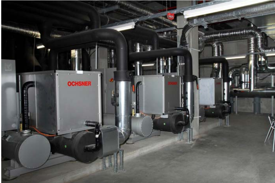
03_IKEA: Die Wärme aus dem Abwasser wird mit Hilfe von drei Großwärmepumpen mit einer jeweiligen Leistung von 500 kW auf rund 35 Grad Celsius gehoben.
