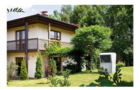
**03\_Luftwärmepumpe\_Garten\_Altbau:** Eine Alternative mit geringerem Erschließungsaufwand sind Luft/Wasser-Wärmepumpen, deren Effizienz in den vergangenen Jahren gegenüber erdgekoppelten Anlagen deutlich aufgeholt hat.
