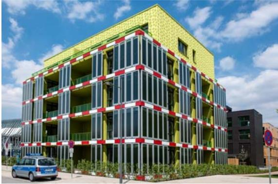
Das Wohnhaus setzt als weltweit erstes Gebäude mit einer Bioreaktorfassade neue Maßstäbe. In den Glaselementen seiner „Biohaut“ werden Mikroalgen gezüchtet, die zur Energieerzeugung genutzt werden und gleichzeitig die Steuerung von Licht und Schatten kontrollieren können. Geheizt wird mit Wärmepumpe. Im Inneren sorgt ein innovatives Wohnkonzept für maximale Gestaltungsfreiheit.
