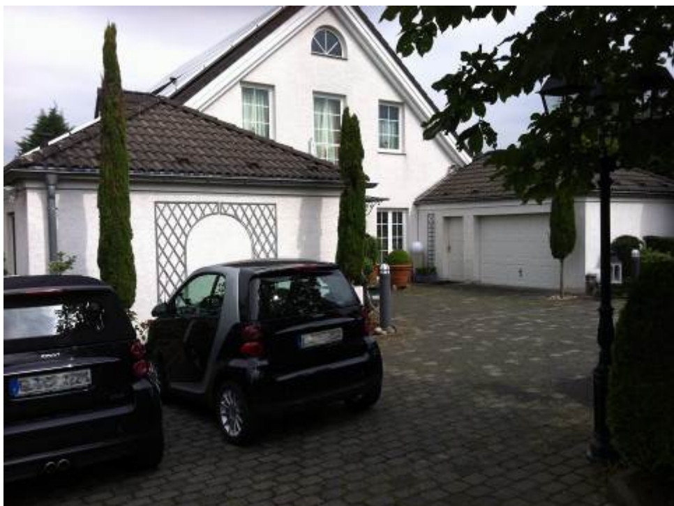
01_Einfamilienhaus in Rösrath: Das 1994 erbaute Haus der Zeidlers wurde 2010 von der Firma WIBATEC mit modernster Haustechnik ausgestattet.
