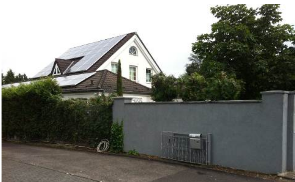
02_Einfamilienhaus in Rösrath: Eine 80m 2 große Solaranlage liefert unter anderem den Strom für die Hochleistungs-Wärmepumpe von Dimplex.
