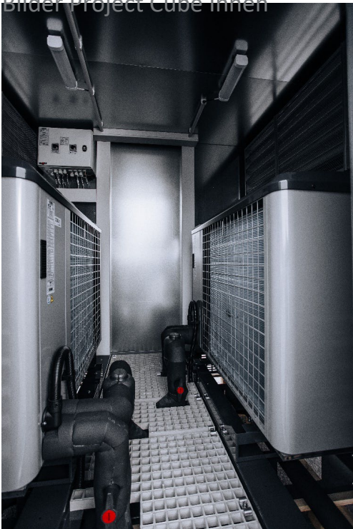
Bilder Project Cube Innen
