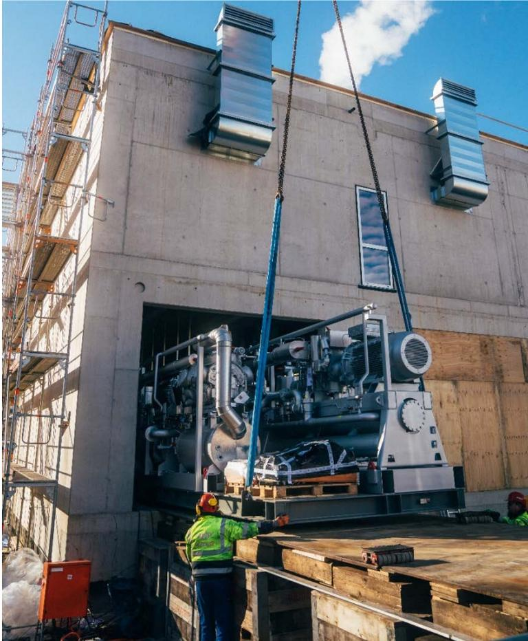
(Einbau der Wärmepumpen ins Müllheizkraftwerk Rosenheim 2022 ©SWRO)
