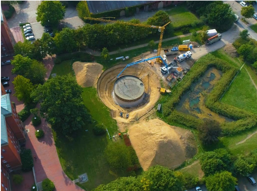
Der Eis-Speicher in Rendsburg wird installiert. © Stadtwerke SH GmbH & Co. KG
