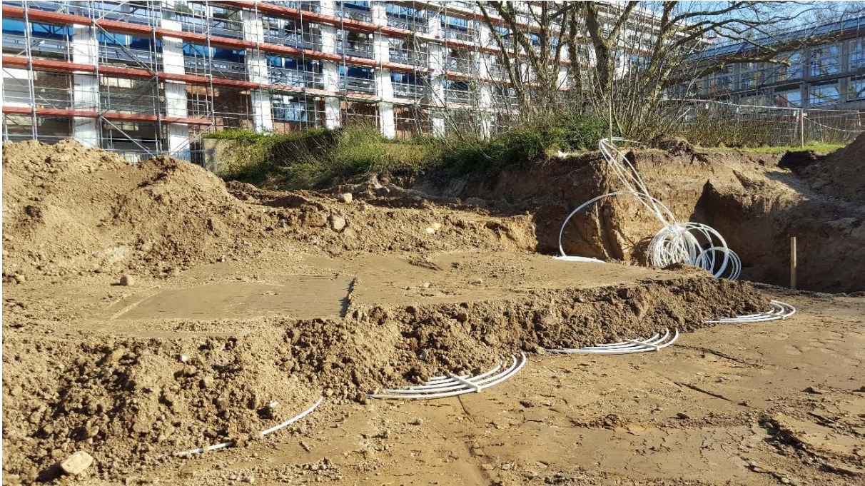
Projekt Noorblick, Erdkollektoren © Stadtwerke SH GmbH & Co. KG
