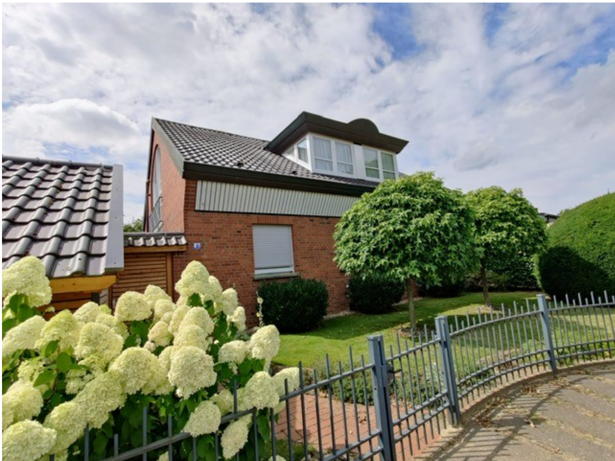
(Modernisierung mit Wärmepumpe in Greven ©KLN)
