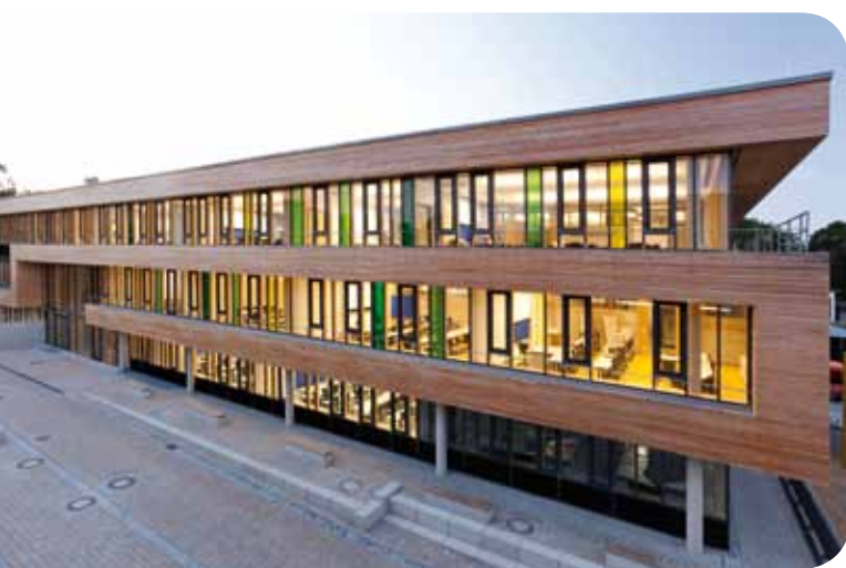
Neue Schule: Eine intelligente Kombination von Photovoltaik und Erdwärme führt zu Höchstleistungen in der Otto-Seeling-Schule in Fürth. Im Sommer bietet die passive Kühlung zusätzlichen Komfort für Lehrer und Schüler. (Quelle: Stadt Fürth)
