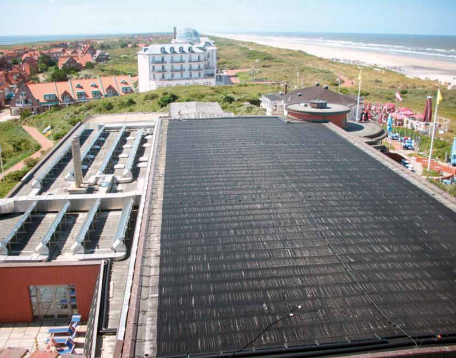
Auf der Sonnenseite: Mit Solarabsorbern und Wärmepumpen heizt die Inselgemeinde Juist ihr Hallenbad wirtschaftlich und ökologisch. (Quelle: Inselgemeinde Juist)
