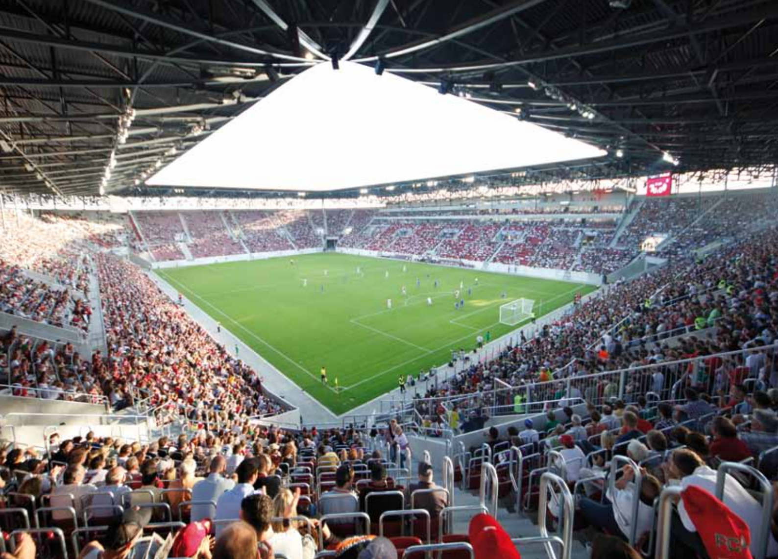
In der impuls arena des FC Augsburg ist nicht nur der Rasen grün: Die umweltfreundliche Energieversorgung funktioniert dank moderner Wärmepumpentechnik. (Quelle: Lechwerke AG/ Fotografin Christina Bleier)
