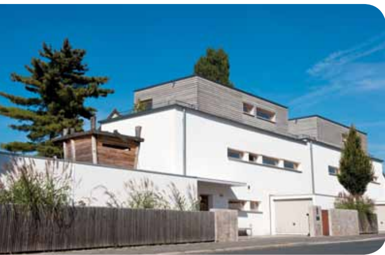
Dieses 2006 neu gebaute Einfamilienhaus wird energieeffizient mit Erdwärme geheizt – das schont nicht nur die Umwelt, sondern auch den Geldbeutel der Familie. (Quelle: BWP)
