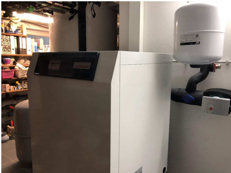
Die Wärmepumpe im Keller der Familie Massmann hilft bereits seit 1999 bei der Senkung der Energieverbrauchskosten. (Bildquelle: Massmann GmbH).
