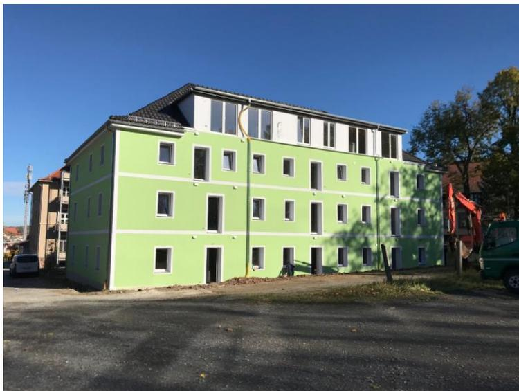
*Neues Kleid für alte Hülle: Die Sanierung des Mehrfamilienhauses in Pirna, sächsische Schweiz, dauert zwei Jahre und beinhaltet die Installation von 11 dezentralen Sole-Wasser-Wärmepumpen mit integriertem Warmwasserspeicher. (Bildquelle: Novelan).*
