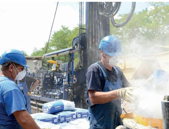
oben: Die Qualität der Ringraumverfüllung kann mit speziellen Sonden bereits während des Verfüllvorgangs überwacht und dokumentiert werden.
