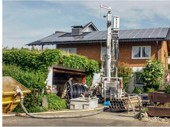
In den Sondenrohren zirkuliert ein **Wasser-Glykol-Gemisch** – die so genannte Sole. Dieses Gemisch transportiert die geothermische Energie aus dem Untergrund zur Wärmepumpe. Die Anlage kann in Sonderfällen (z. B. in Wasserschutzgebieten) auch mit reinem Wasser betrieben werden.
