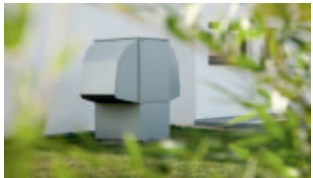
Abb. 5.2 Luft-Wasser-Wärmepumpe in Außenaufstellung
