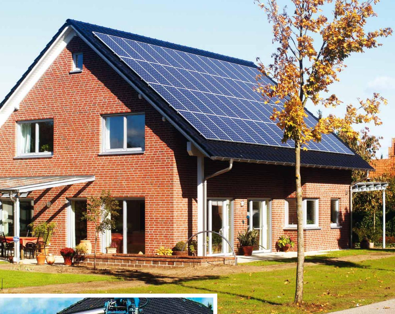
**Keine Dachfenster, keine Gauben: Die gesamte Fläche kann für die Module genutzt werden.**
