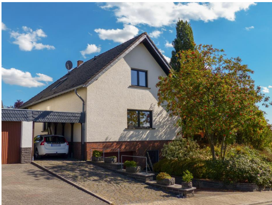
Bei der Umrüstung des Einfamilienhauses in Kehrigh wurden weder Arbeiten an der Fassade, noch im Garten notwendig. (Bildquelle: BWP)
