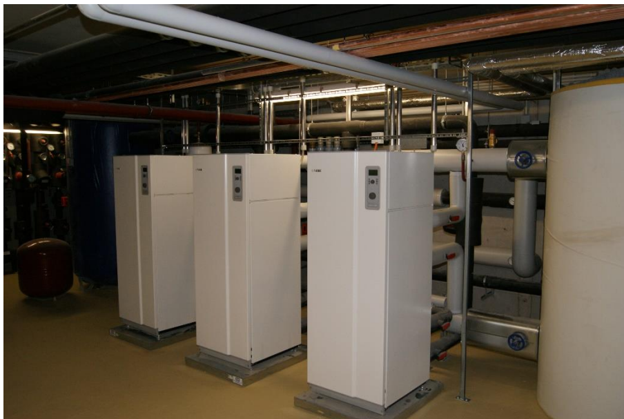
Drei Wärmepumpen sorgen im Strahlentherapiezentrum am Kemperhof energieeffizient für Wärme und Kälte. (Bildquelle: Wagner GST GmbH).
