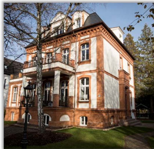
BU: Modernisieren mit Wärmepumpe funktioniert in den meisten Fällen problemlos (BWP).
