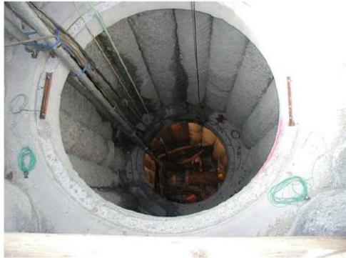
Bild 2-3: Dükerschacht in Bau
