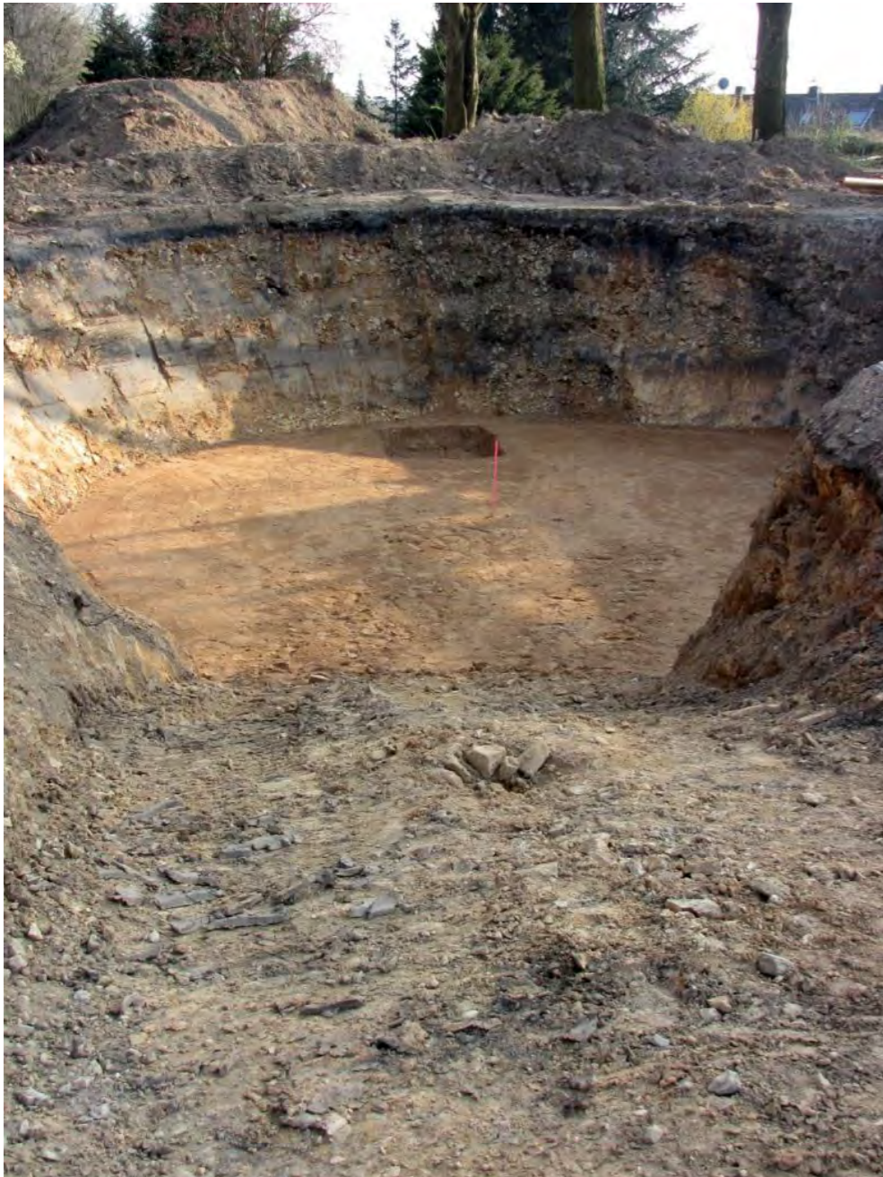
Die Grube für den Eisspeicher
