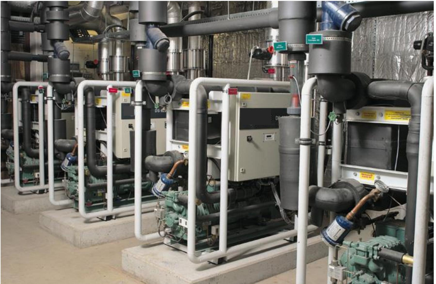
4 Wärmepumpenmodule mit einer Heizleistung von 840 kW
