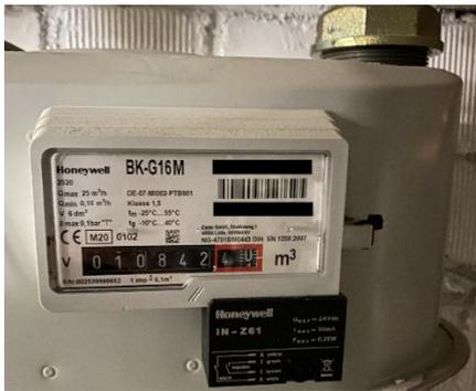
Abbildung 5: Gaszähler mit Reedkontakt als Impulsgeber
