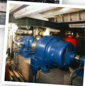
Im Zürcher Rathaus wird eine 100-Kilowatt-Wärmepumpe zum Heizen und Kühlen eingeweiht – mit Flusswasser als Wärmequelle. Sie war dort bis zum Jahr 2001 alleiniger Lieferant von Heizenergie und ist heute die älteste noch funktionierende Wärmepumpe.
