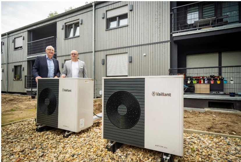
Bild 2: Die Mehrfamilienhäuser in Mönchengladbach wurden mit vorgefertigten Holzfassaden versehen, inklusive Lüftungstechnik und Dämmung. So ausgestattet, bieten die Häuser gute Voraussetzungen für den effizienten Betrieb der neuen Wärmepumpen./BWP
