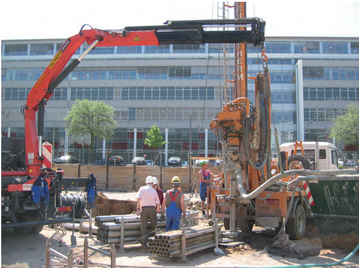
Abb. 2: Bohrung für Erdwärmesonden (Quelle: BWP)
