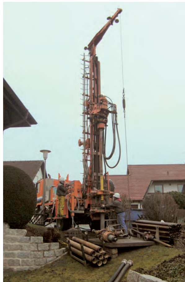
Abb. 1: Bohrung für Erdwärmesonden (Quelle: LfU)
