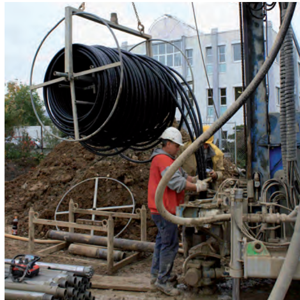
Abb. 7: Einbringen einer Erdwärmesonde (Quelle: LfU)
