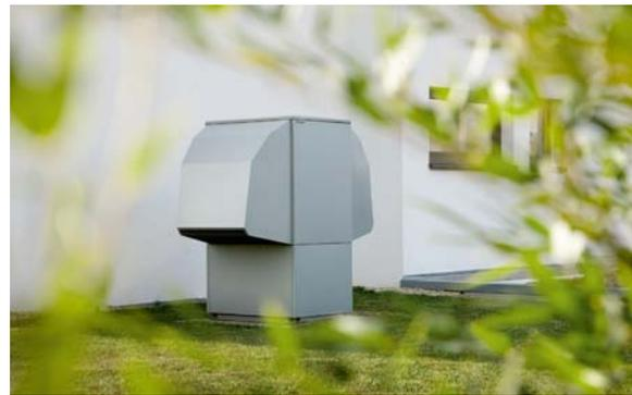
Abb. 5.2 Luft/Wasser-Wärmepumpe in Außenaufstellung
