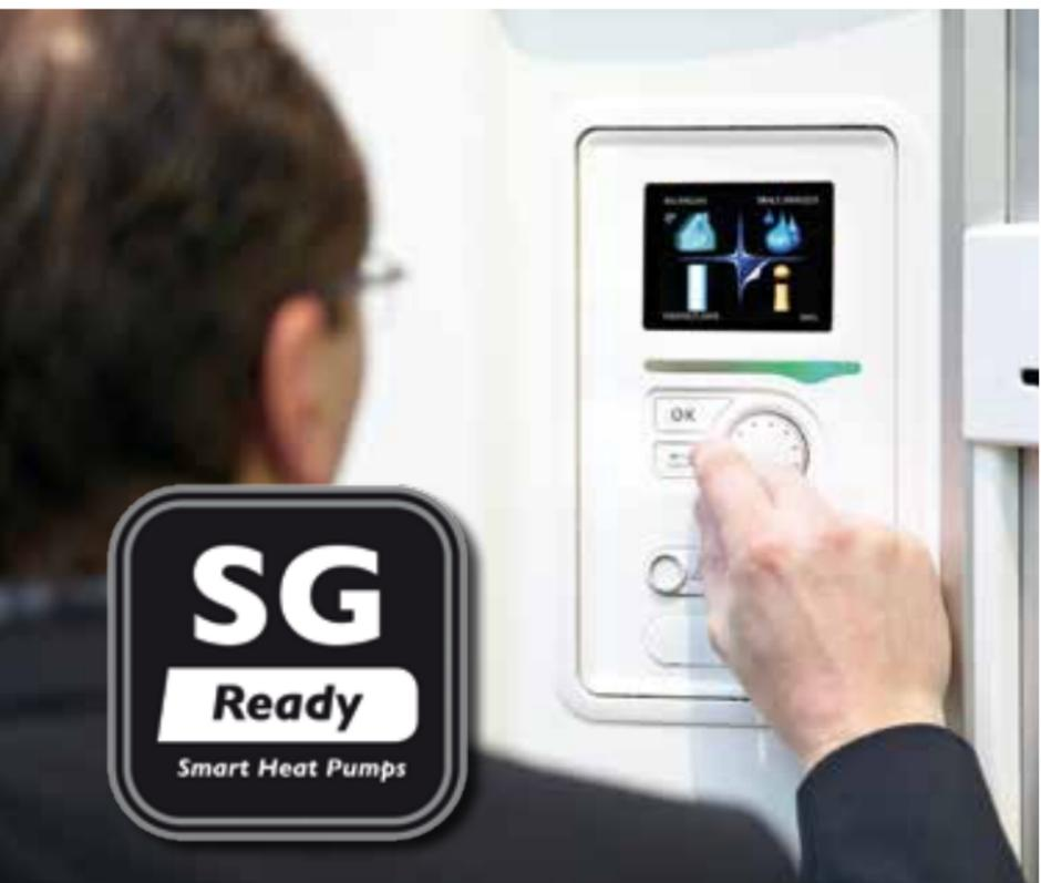
In Zukunft können Wärmepumpen aber genauso einfach in ein intelligentes Stromnetz (Smart Grid) eingebunden werden, wo die Erzeugung und der Stromverbrauch regional oder sogar landesweit aufeinander abgestimmt werden. Wärmepumpen mit einem SG-Ready-Label sind bereits ideal auf zukünftige Tarifmodelle vorbereitet und können die zukünftigen, variablen Tarife ideal ausnutzen. Daraus können sich beträchtliche Kostenvorteile ergeben.
